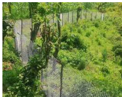
उद्यानको सिमानामा भएको फेन्सिङ्ग निर्माण
