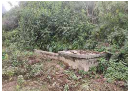
खानेपानी ट्याङ्की निर्माण
