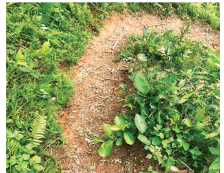
गोरेटो बाटो निर्माण
