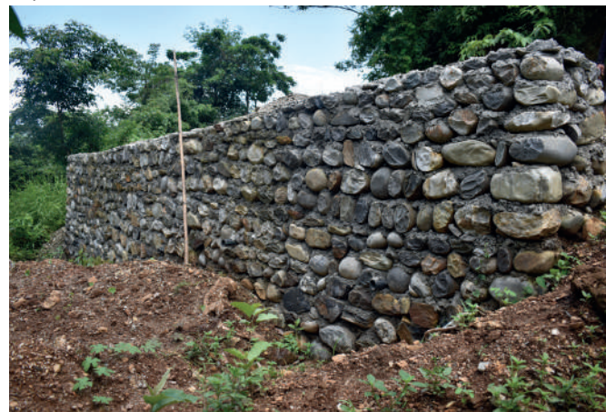
रिटेनिड वाल निर्माण
