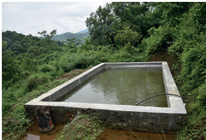
वन्यजन्तुका लागि पानीपोखरी निर्माण
