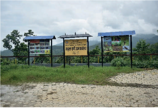
साईनबोर्ड/सूचना बोर्ड निर्माण
